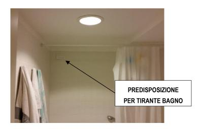
L'intervento pertanto prevede l'installazione del pulsante tirante bagno ed il cablaggio dei cavi verso il Room Controller di stanza, come mostrato negli elaborati di progetto.
